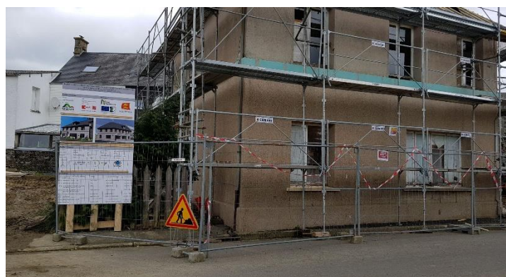
Rachetée par la Semivir, l'ancienne boucherie de Truttemer-le-Grand a été transformée par la Sem en salon de coiffure, cabinet infirmier et appartements. @Mairie de Vire Normandie
