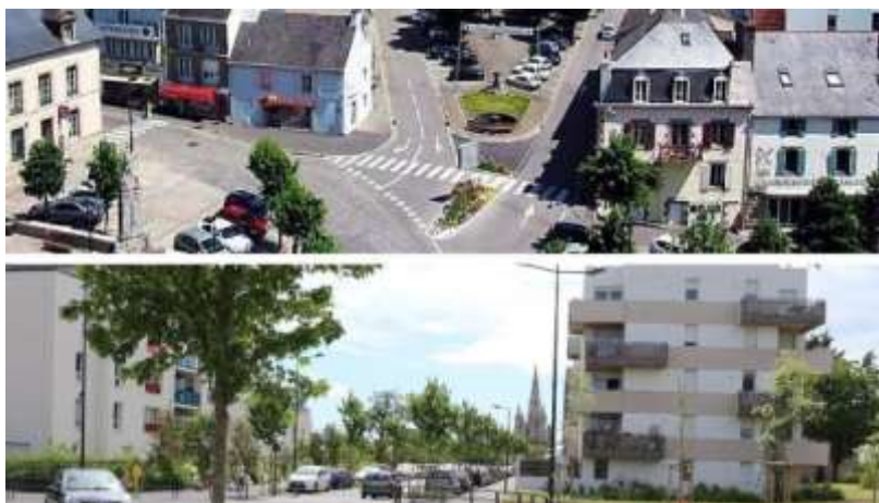
« Avant, le quartier vu du clocher de la basilique. Après, la ZAC Centre aujourd'hui. Seize ans séparent ces deux photos. La Zac centre est désormais terminée ». © Ouest-France
