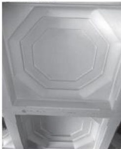
LA POUTRAISON DES PLANCHER FORMENT UN PLACOND DECORATIF A CAISSON
