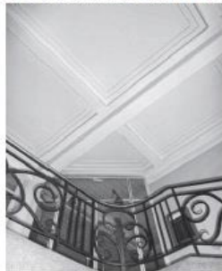
LA POUTRAISON DES PLANCHER FORMENT UN PLACOND DECORATIF A CAISSON
