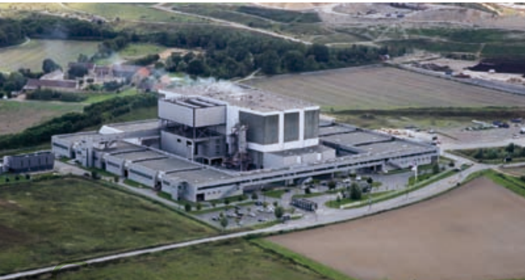
Semardel permet aux 740 000 habitants des 129 communes du Siredom de bénéficier de tarifs de traitement de déchets parmi les plus bas d'Ile-de-France - Vue générale de l'Ecosite de Vert-le-Grand / Echarcon. © Semardel
