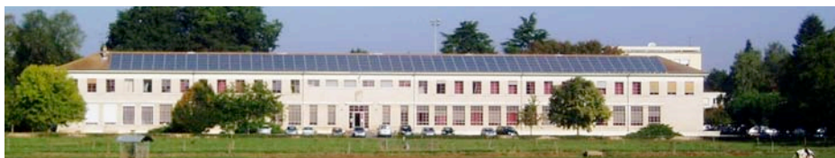
Installation sur un Lycée Agricole / Crédit photo Sergies
